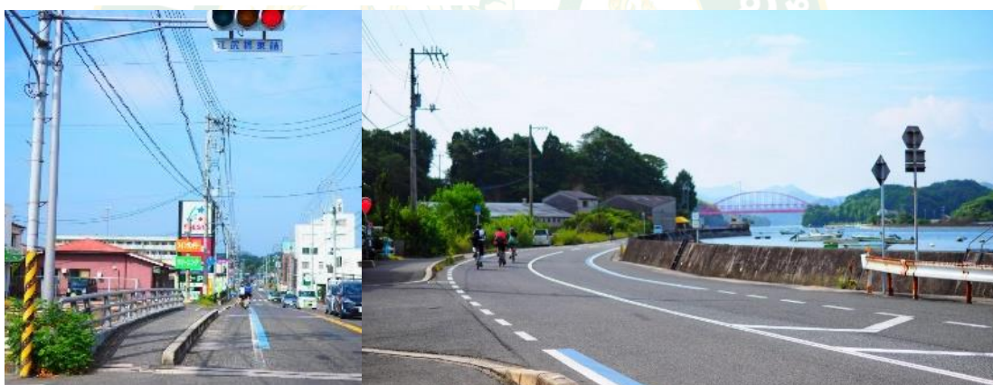
ภาพที่ 49 : ทางจักรยานใช้ขอบทางหรือไหล่ทางของถนนเป็นเส้นทางจักรยาน ที่มีการออกแบบให้มีวัสดุสีที่แตกต่างจากถนนทั่วไป
