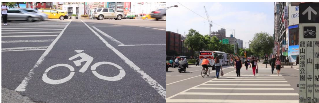
ภาพที่ 33 : ทางจักรยานที่ใช้พื้นที่ร่วมกันกับการจราจรประเภทอื่นมีเส้นแบ่งบอกชัดเจน
