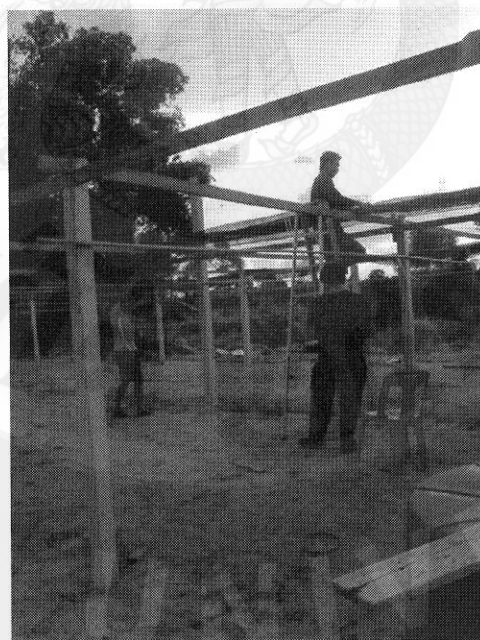
ภาพผนวกที่ 2 การติดตั้งเสาปูน เพื่อทำโรงเรือนชั่วคราว
