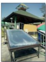
(ก) ตัวเก็บรังสีอาทิตย์แบบแผ่นเรียบ ขนาด 2.4 m 2
