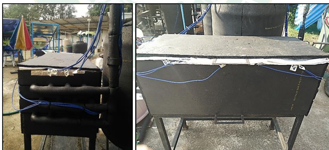
ภาพที่ 30 หุ้มฉนวนบริเวณอุปกรณ์แลกเปลี่ยนความร้อน
