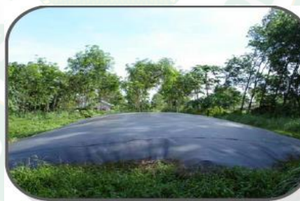
ภาพที่ 6 ระบบคัฟเวอร์ ลากูน (Covered Lagoon)
