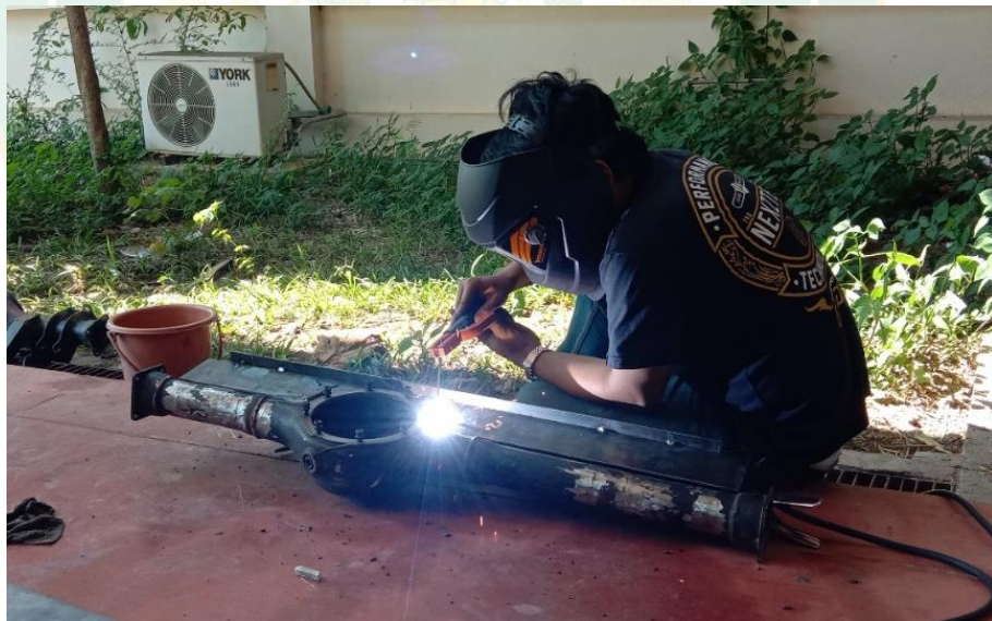
ภาพที่ 30 เหล็กคานเสริมความแข็งแรง
