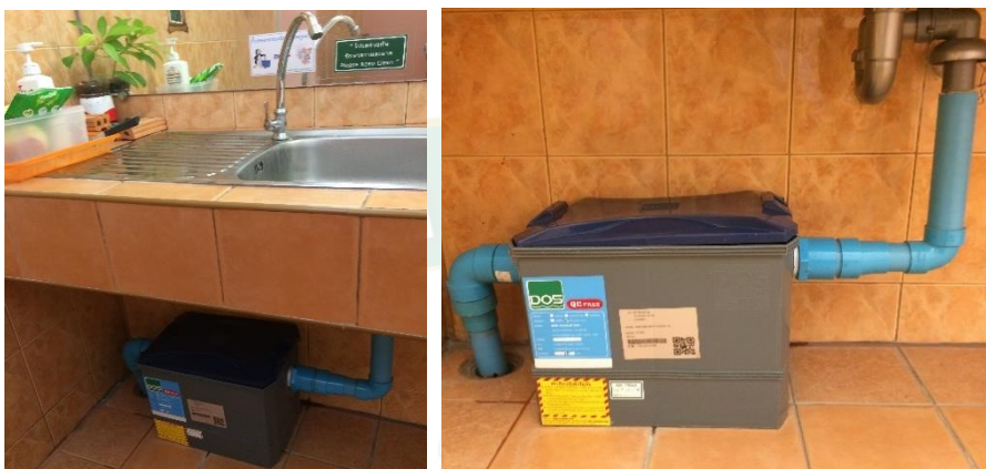
ภาพที่ 12 แสดงจุดที่ติดตั้งถังดักไขมันเพื่อช่วยในการดักกรองเศษอาหาร
