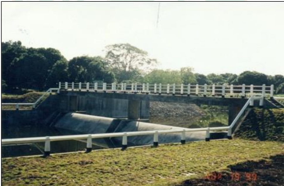
ภาพที่ 23 ฝ่ายทดน้ำน้ำย่อยพร้อมระบบผันน้ำ
