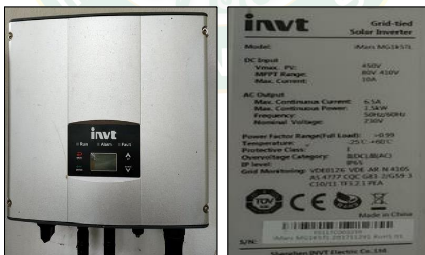
(ข) อินเวอร์เตอร์ที่ต่อเข้ากับระบบผลิตไฟฟ้าและน้ำร้อนพลังงานแสงอาทิตย์
