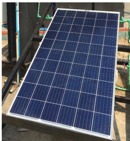
ภาพที่ 22 แผงผลิตไฟฟ้าและน้ำร้อนพลังงานแสงอาทิตย์แบบไม่มีกระจก
