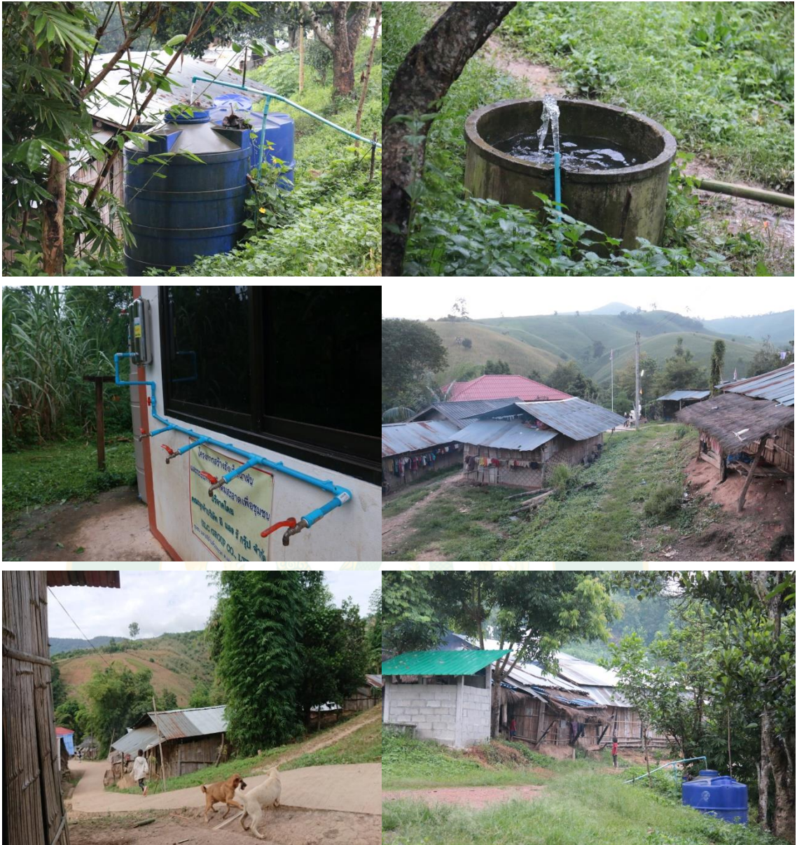
ภาพผนวกที่ 5 ระบบสาธารณูปโภคภายในชุมชน ประกอบด้วย ประปาภูเขา ไฟฟ้า ถนนคอนกรีต และมีส่วนร่วม
