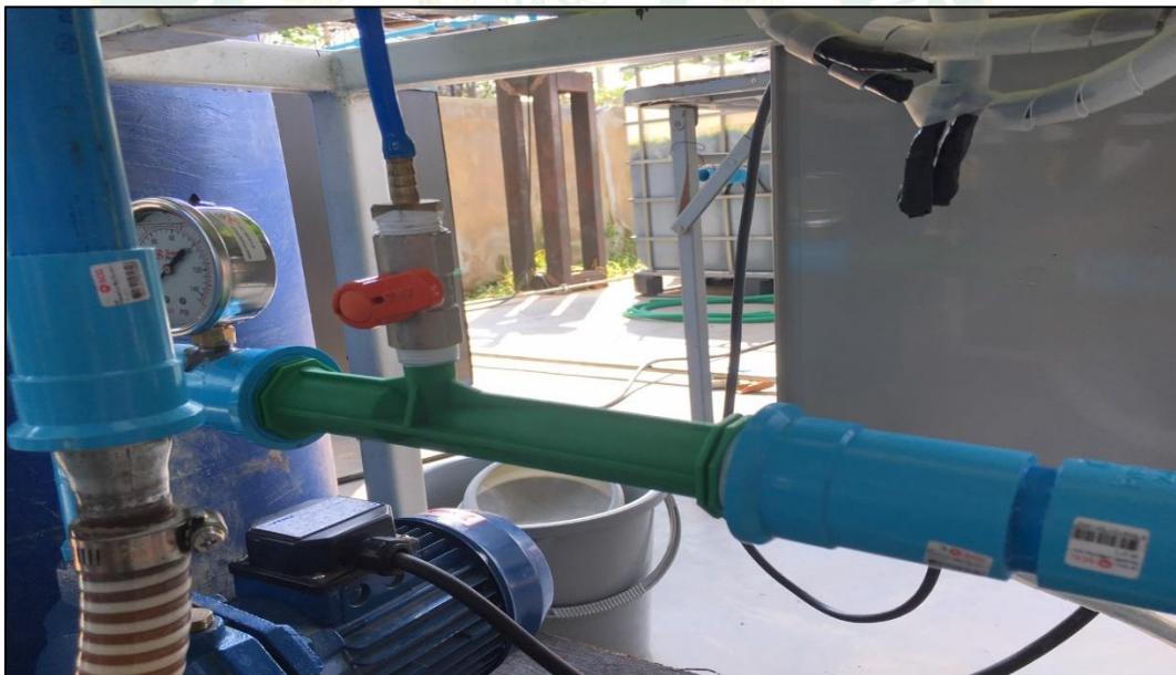
ภาพที่ 33 ระบบการหมุนวนน้ำและก๊าซชีวภาพ
