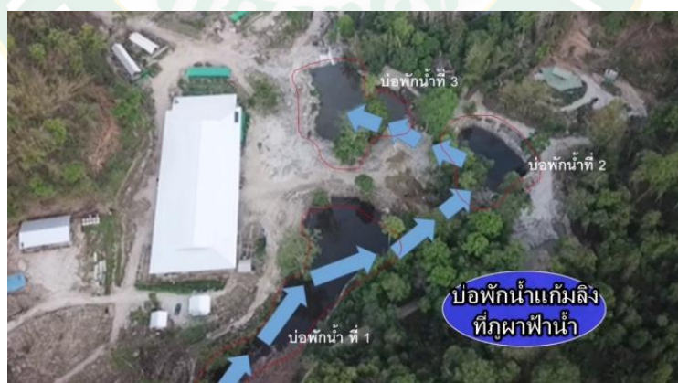
ภาพที่ 31 บ่อพักน้ำแก้มลิง
