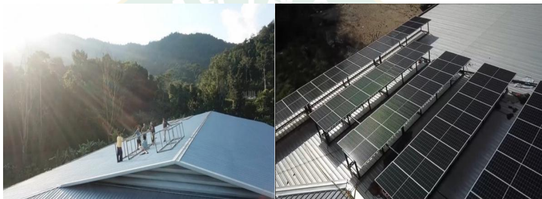
ภาพที่ 39 การติดตั้งโซลาร์เซลล์
