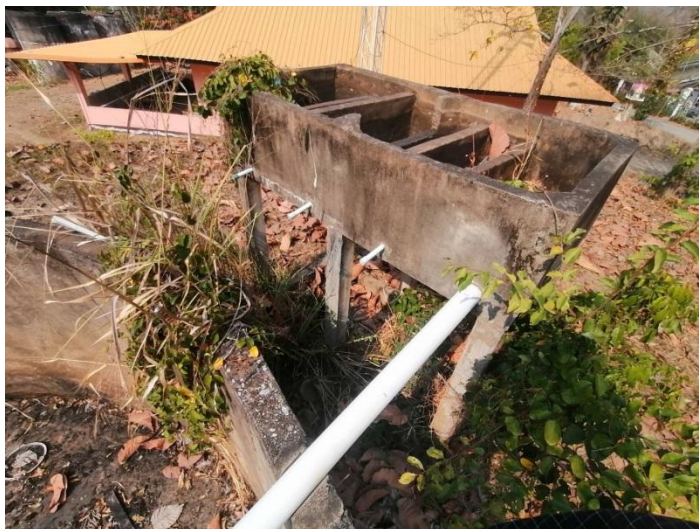
ภาพที่ 24 ระบบกรองน้ำบ่อซีเมนต์หมู่บ้านห้วยตึงเฒ่า ปี พ.ศ. 2531
