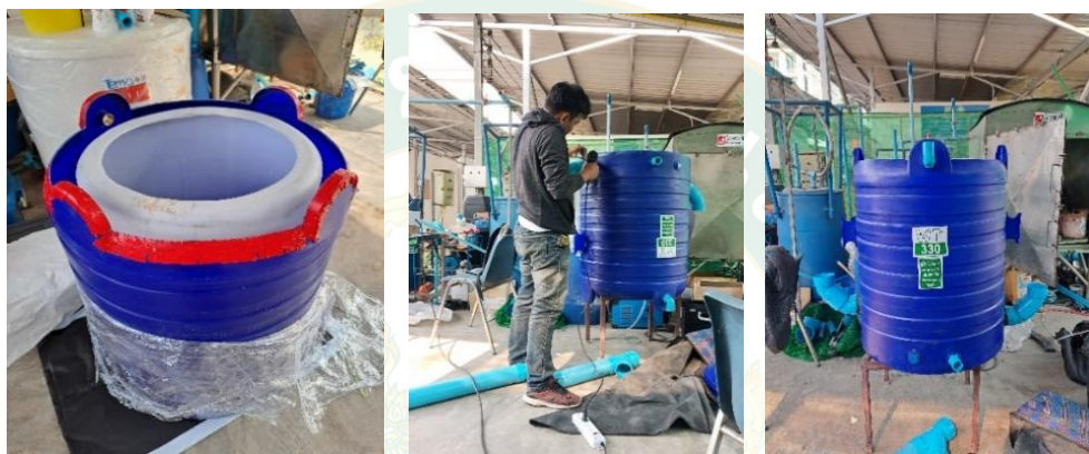
(ก) การเจาะเปิดปากถัง (ข) การนำท่อมาเชื่อมกับถังด้านนอก (ค) การนำท่อมาเชื่อมกับถัง
