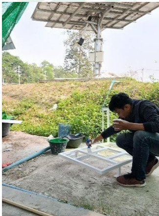
(ก) การทาสีเคลือบเหล็ก
