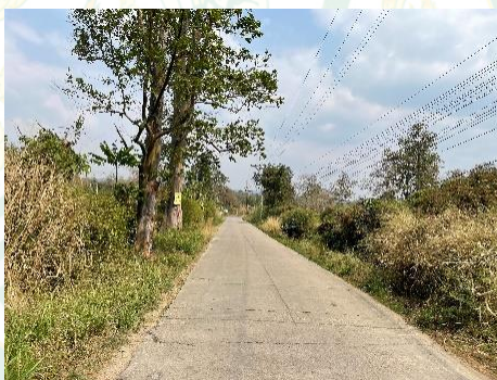
ภาพที่ 5 ถนนคอนกรีตเสริมเหล็ก
