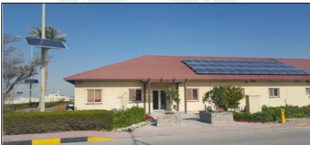
ภาพที่ 22 การติดตั้งแผงเซลล์แสงอาทิตย์ขนาด 240 Wp จำนวน 36 แผง ขนาด 8.64 kW (Gholami et al., 2019)
