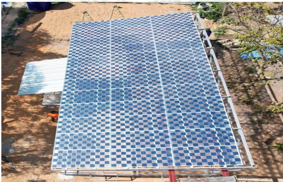
ภาพที่ 49 การติดตั้งแผงเซลล์แสงอาทิตย์ชนิดกึ่งโปร่งใสบนหลังคาโรงเรือน
