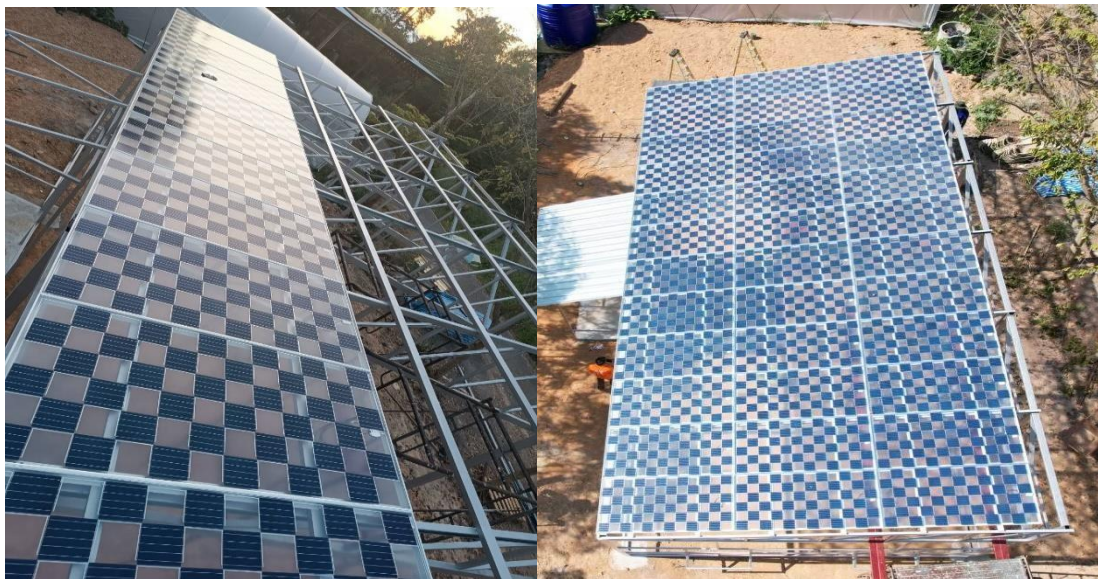
ภาพที่ 89 โรงเรือนปลูกพืชและการติดตั้งแผงเซลล์แสงอาทิตย์กิ่งโปร่งใสในรูปแบบการจัดวางเซลล์แบบหมากรุก
