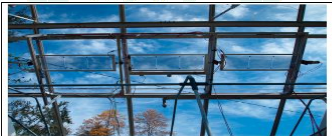
ภาพที่ 27 การติดตั้งแผงเซลล์แสงอาทิตย์แบบกึ่งโปร่งใสนบนหลังคา (Gholami et al., 2019)
