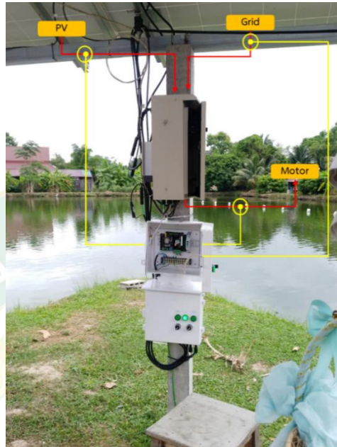
รูปที่ 61 การติดตั้งระบบตรวจวัดในระดับ Commercial scale
