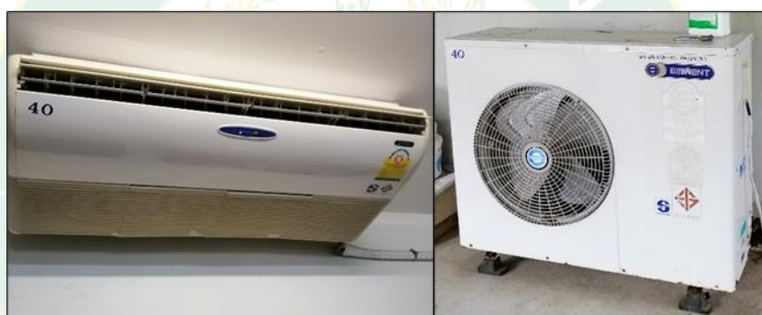
ก) คอยล์เย็น (Fan Coil Unit)
