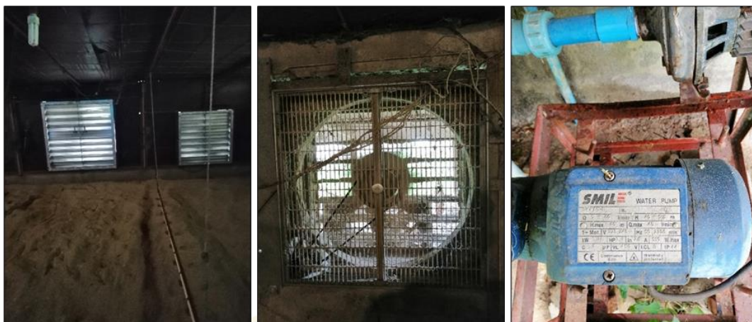
ภาพที่ 82 ลักษณะอุปกรณ์พัดลมและปั้มน้ำของระบบระบายอากาศในฟาร์มสัตว์ปีก
