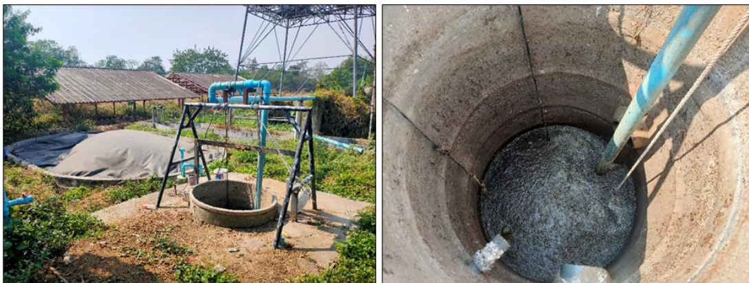
(ก) ระบบแก๊สชีวภาพที่เสียหายของระบบผลิตแก๊สชีวภาพหมักแบบ UASB
