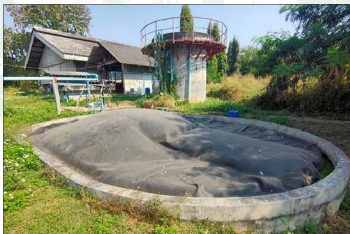
ภาพที่ 101 ระบบผลิตแก๊สชีวภาพหมักแบบ UASB (Up flow Anaerobic Sludge Blanket) ในพื้นที่ฟาร์มสุกรภายในคณะสัตวศาสตร์และเทคโนโลยี มหาวิทยาลัยแม่โจ้
