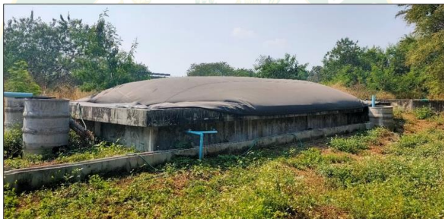
ภาพที่ 99 ระบบผลิตแก๊สชีวภาพแบบโดมคงที่ (Fixed Dome) ขนาด 200 m 3
