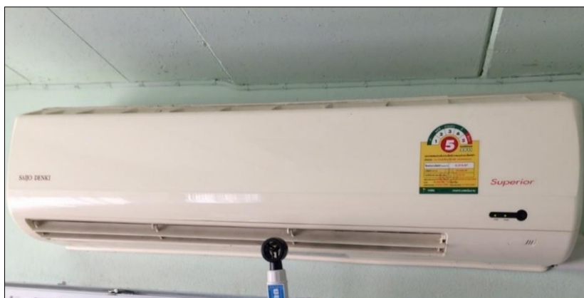
ภาพที่ 55 ตรวจสอบวัดค่าอุณหภูมิ ความชื้นสัมพัทธ์ และความเร็วลม ช่องส่งลมเย็นและช่องลมกลับ
