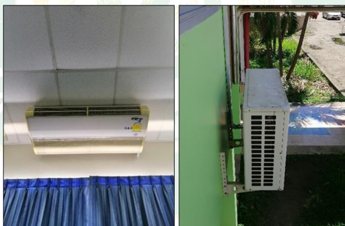
ภาพที่ 78 ลักษณะเครื่องปรับอากาศแบบแยกส่วน (Split Type) ของอาคารศูนย์สัตวศาสตร์และเทคโนโลยี
