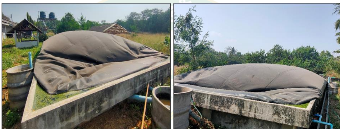
(ข) ระบบแก๊สชีวภาพที่เสียหายของระบบผลิตแก๊สชีวภาพแบบโดมคงที่ (Fixed Dome)
