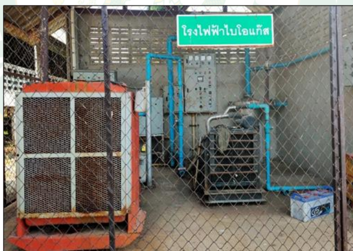
ภาพที่ 96 โรงไฟฟ้าแก๊สชีวภาพกำลังการผลิต 60 kW
