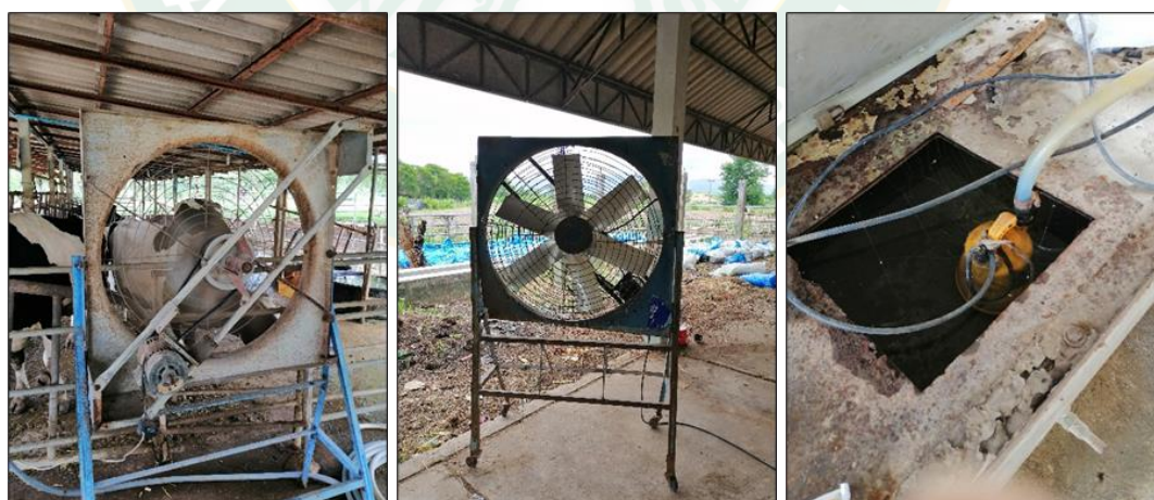
ภาพที่ 83 ลักษณะอุปกรณ์พัดลมและปั้มน้ำของระบบระบายอากาศในฟาร์มโคนม-โคเนื้อ
