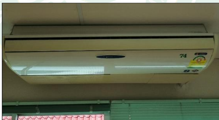
ภาพที่ 91 ตัวอย่างเครื่องปรับอากาศแบบแยกส่วนภายในอาคารที่มีอายุการใช้งาน 15 ปี
