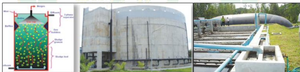
ภาพที่ 40 ระบบผลิตแก๊สชีวภาพแบบ UASB และ H-UASB
