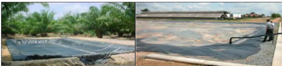
ภาพที่ 38 ระบบผลิตแก๊สชีวภาพแบบพลาสติกคลุมบ่อดิน
