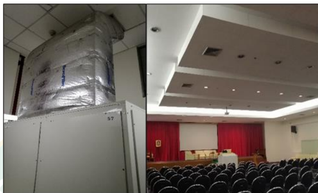
ภาพที่ 21 ระบบปรับอากาศแบบชุดหรือแพ็คเกจ (Package)
