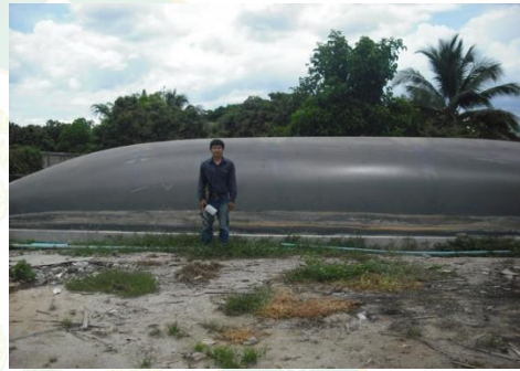
บ่อไร้อากาศแบบคลุมบ่อ
