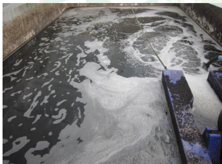
บ่อเติมอากาศ
