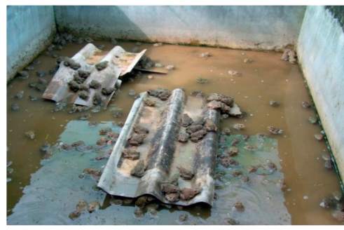
ภาพที่ 8 บ่อซีเมนต์เหลี่ยม
