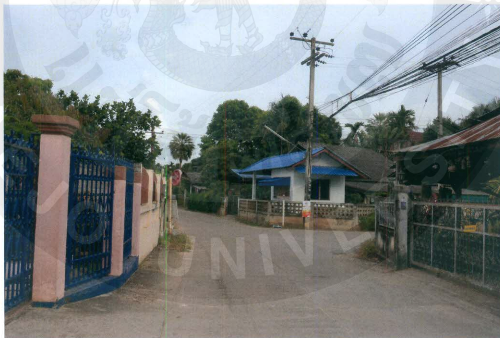
ภาพที่ 9 สภาพถนนคอนกรีตเสริมเหล็กภายในหมู่บ้าน
