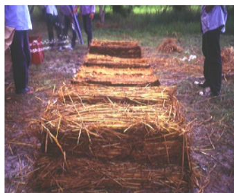
เมื่อเสร็จขั้นสุดท้ายนำฟางข้าววางไว้ ด้านบนสุดหนา 5 ซม. ใช้มือกดให้แน่น จากนั้นรดน้ำและถอดแบบพิมพ์ออก
