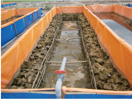
(ก) การเตรียมแผงไม้ไผ่และดินภายในบ่อ
