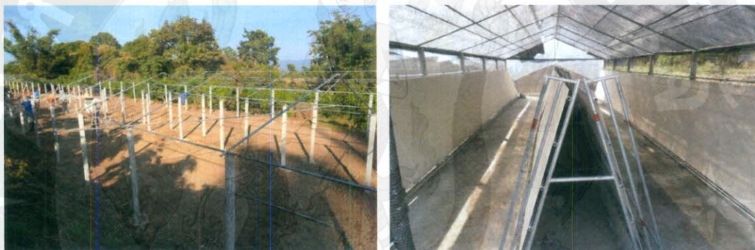
ภาพที่ 16 มาตรฐานโรงเรือนเห็ดหลินจือสายพันธุ์ MG 2 ขนาด 4 x 12 เมตร ความจุ 5,000 ก้อน
