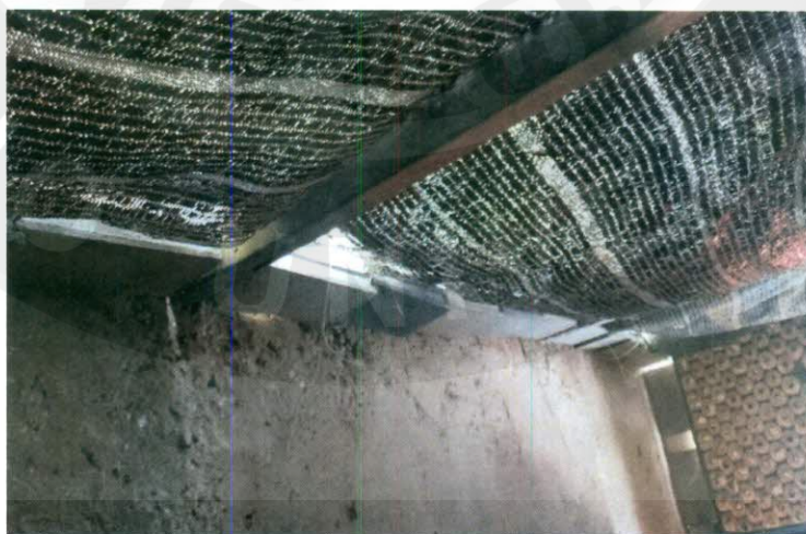
ภาพที่ 20 การนำอิฐบล็อกติดตั้งระบบน้ำภายในโรงเรือนเพื่อเพิ่มความชื้นและลดอุณหภูมิภายในโรงเรือน ในจังหวัดขอนแก่น
