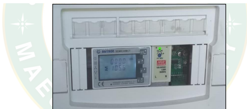
ภาพที่ 19 เครื่องวัดค่าพลังงานไฟฟ้า ยี่ห้อ Eastron รุ่น SDM630MCT
