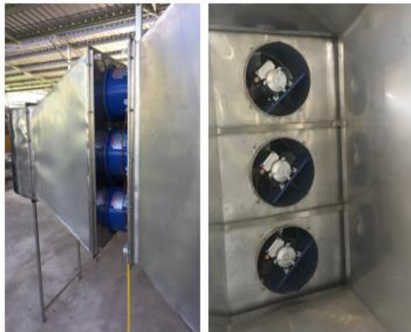
ภาพที่ 26 การติดตั้งพัดลมสำหรับหมุนเวียนอากาศภายในระบบบอบแห้ง
