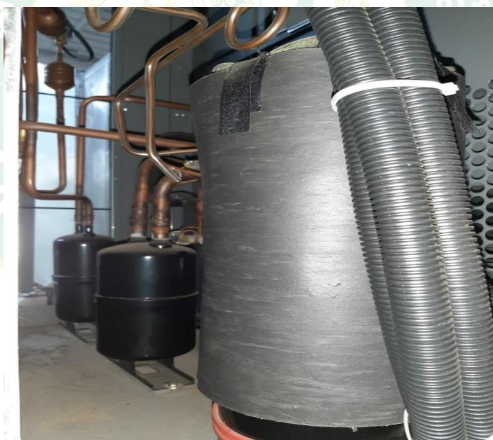
ภาพที่ 19 เครื่องอัดไอ (Compressor) แบบก้านหอย
