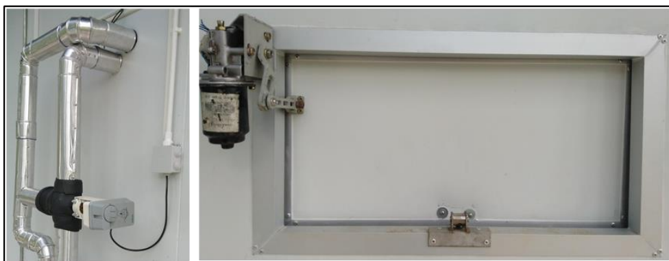
ภาพที่ 45 วาล์วสามทางไฟฟ้า (ซ้าย) มอเตอร์ไฟฟ้า (ขวา)
