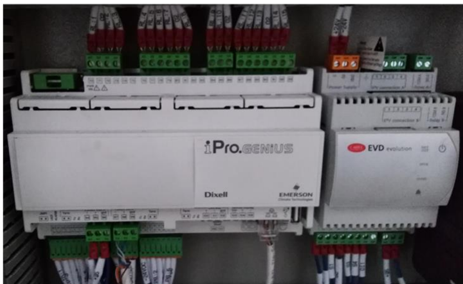
ภาพที่ 31 พีแอลซีควบคุมของวิศวจักรแรงคินสารอินทรีย์
