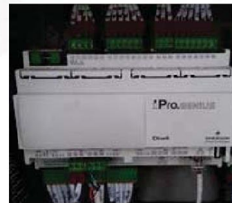
รูปที่ 8 ส่วนควบคุมหลักของวัฏจักรแรงดันสารอินทรีย์
